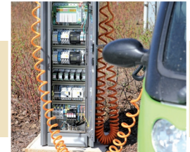
Für die Infrastruktur
